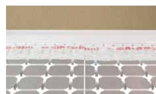
4. posa pannello isolante R883-1 con profilo termoconduttore in alluminio accoppiato
